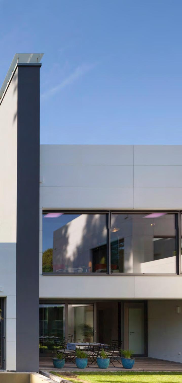
paneli su montirani od strane građevinske kompanije Kiebitzberg korišćenjem aluminijumskih konstrukcija koje je napravio BMW Montagetechnik. HI-MACS ® FR elementi (u alpsko beloj), koji su specijalno dizajnirani za spoljnu upotrebu, su fiksirani na strukturama sa Keil insertacijama, koje su nevidljive spolja. Mineralni materijal se sastoji od 70% prirodnog kamenog prahu, 25% visokokvalitetne akrilne smole, 5% prirodnih pigmenata, a izuzetno je otporan na habanje i veoma izdržljiv.
